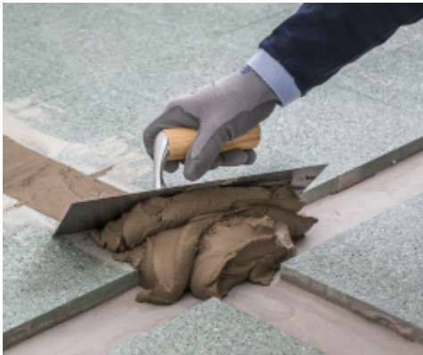
Füllen von Aussparungen mit Planipatch Xtra
